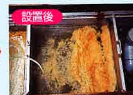
※グリーストラップとは厨房等により排出される油脂の排水管への付着防止の為に設ける油溜めのことです。
