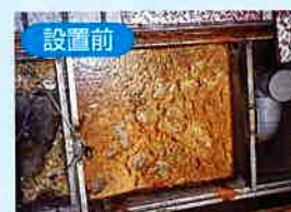
※グリーストラップとは厨房等により排出される油脂の排水管への付着防止の為に設ける油溜めのことです。
