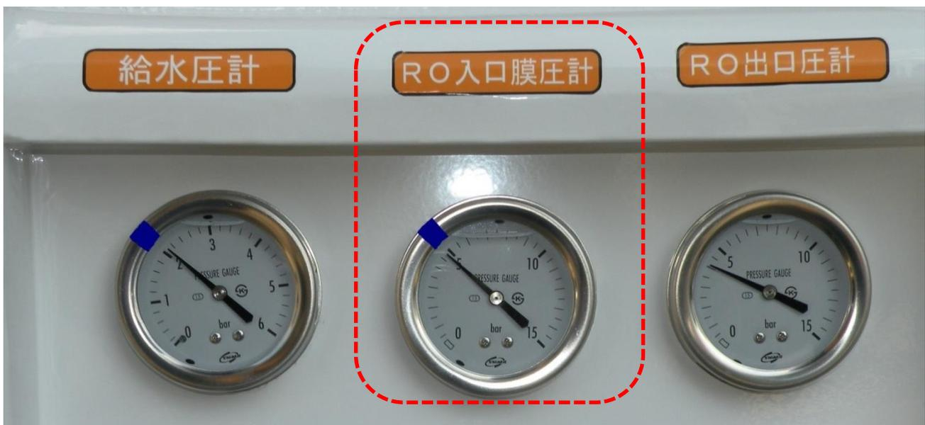
※RO 出口圧計は、逆浸透膜 (RO 膜) の詰まり具合を表します。
